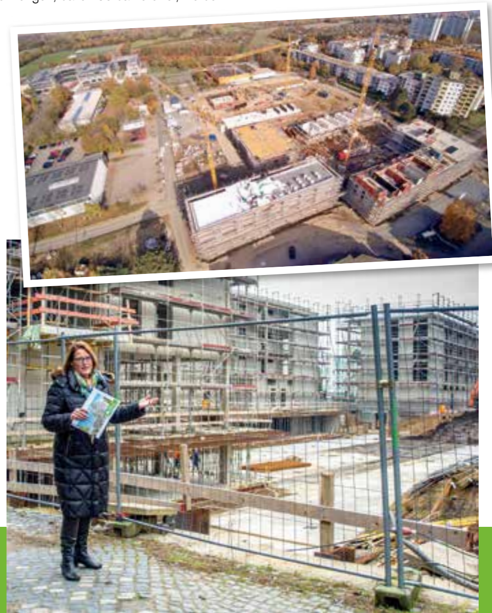
Nibelungen -Wohnbau-Geschäftsführerin Maren Sommer-Frohms am Baufeld des Alsterplatzes
